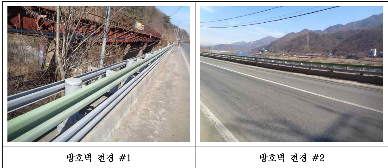
【사진 1.3.23】 방호벽 전경
