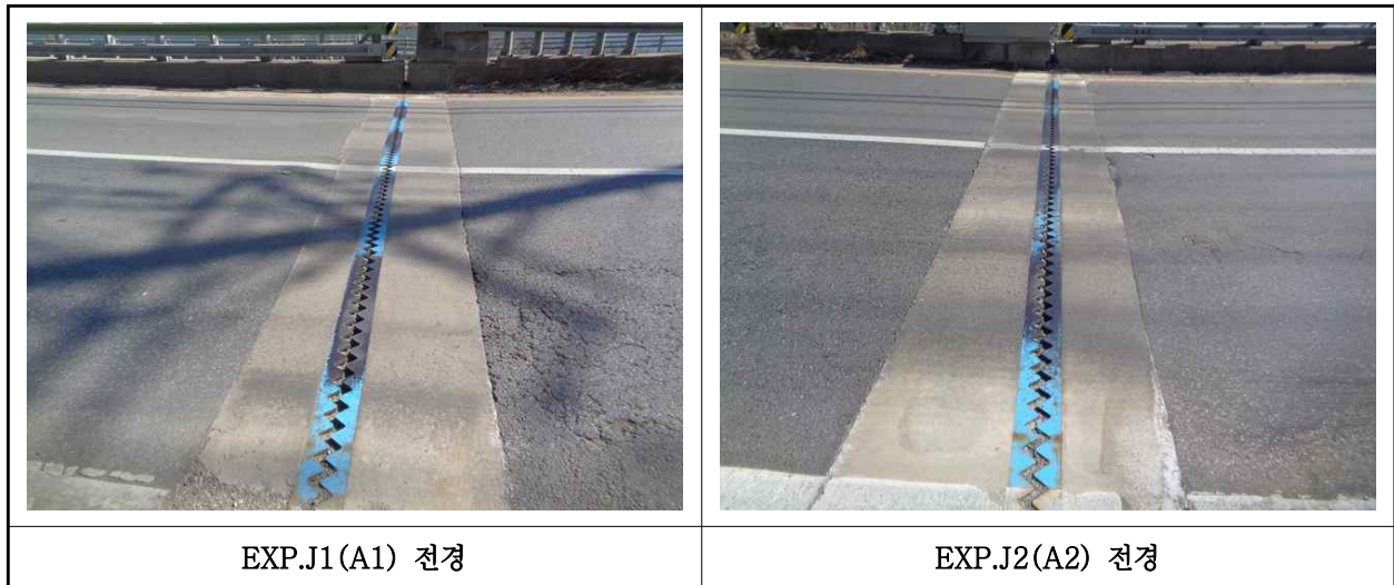
【사진 1.3.16】 신축이음장치 전경
