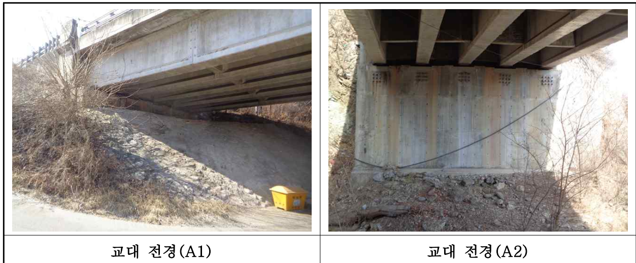
【사진 1.3.8】 교대 전경
