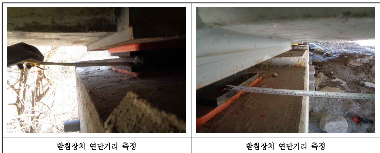
【사진 1.3.14】 교량받침장치 연단거리측정
