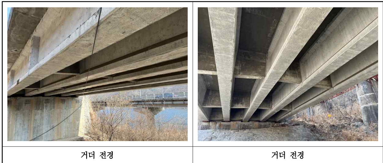
【사진 1.3.4】 거더 전경
