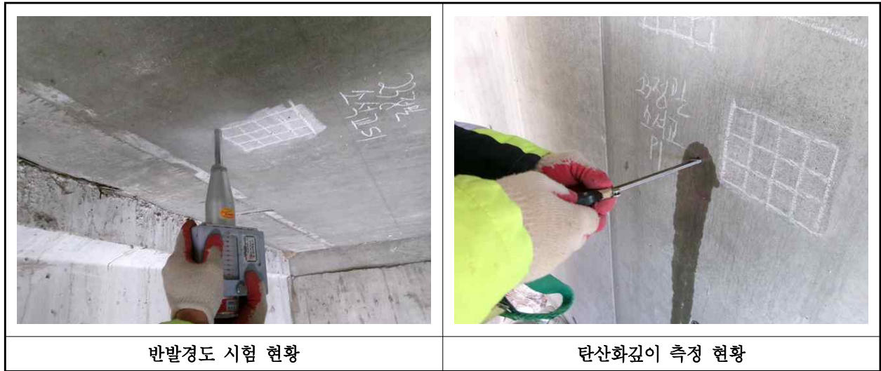
【사진 1.4.1】 콘크리트 내구성조사 현황
