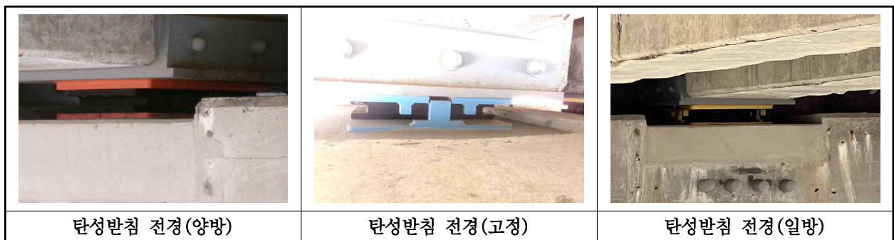
【사진 1.3.12】 교량받침 전경
